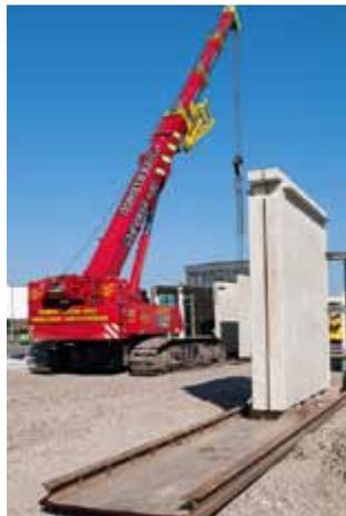
Die Montage der Tragkonstruktion auf dem Bauplatz wurde im Oktober abgeschlossen. Dabei wurden ca. 200 Betonfertigteile montiert, die eine Länge von bis zu 8,80 m aufweisen und dabei bis zu 10 Tonnen wiegen.
